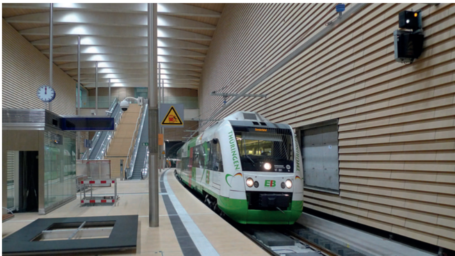
Abb. 4: Videomessfahrten mit Itino der Erfurter Bahn am Hp. Markt des City-Tunnels Foto: V. Kolmorgen
