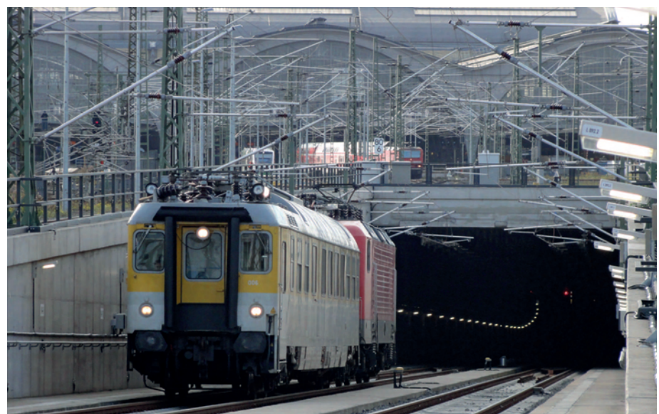
Abb. 3: Oberleitungsabnahmefahrt an der Nordrampe des City-Tunnels
